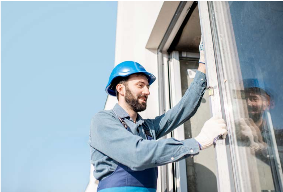
Abb. 77 Montagearbeiten auf der Baustelle
