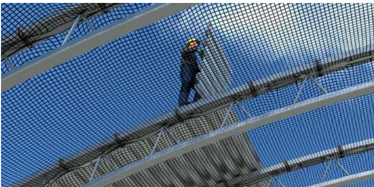
Abb. 96 Verlegen von Profiltafeln auf dem Dach
