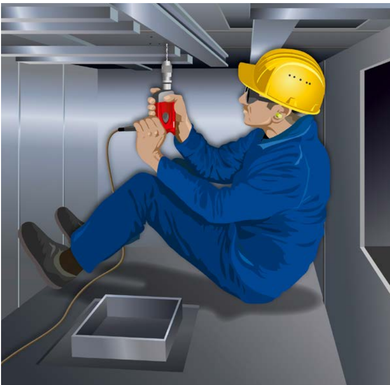
Abb. 14 Arbeiten mit elektrischer Bohrmaschine unter erhöhter elektrischer Gefährdung
